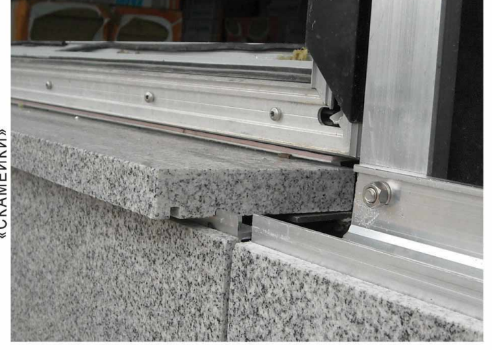
DETALJ PROZORSKE KLUPICE УЗЕЛ ОКОННОЙ ПЕРЕМЫЧКИ - «СКАМЕЙКИ»
