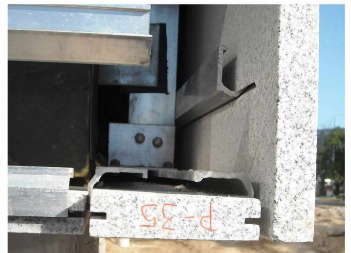
DETALJ IZNAD PROZORA УЗЕЛ НАД ОКОННЫМ ПРОЕМОМ
