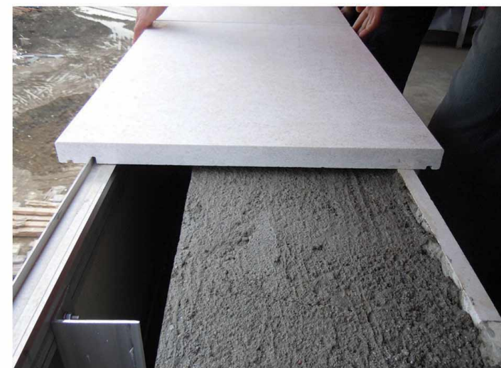
DETALJ POKROVNE PLOČE NA TERASI УЗЕЛ ПОКРЫВНОЙ ПЛИТЫ НА ТЕРРАСЕ
