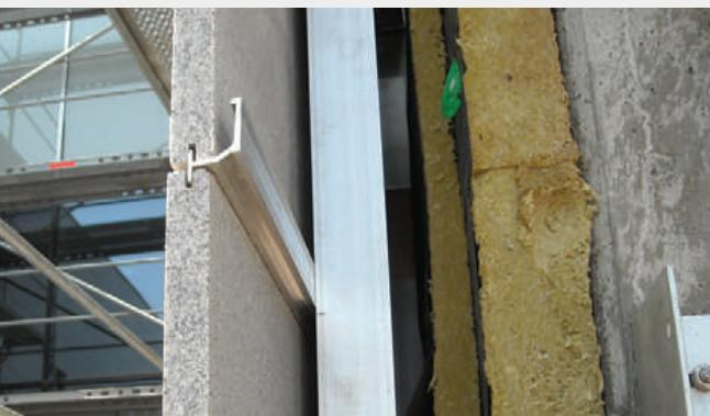
vertikalnog nosača L-'TV" vrši sa gornje (na gore) ili donje (na dole) strane, primarnog nosaca "TAp", koji je sa već formiranim otvorima za zavrtnjeve i ankere. Vertikalni L nosači se uglavnom postavljaju na 100cm medusobnog odstojanja, za deblijnu kamenih ploča od d=3cm.
