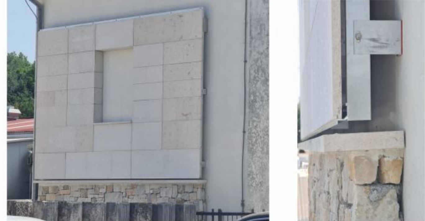
MOCK UP kamene ventilirane fasade sa potkonstrukcijom - Pazin, sa sajma MOCK UP kamene ventilirane fasade sa potkonstrukcijom - Nemačka Ambasada, Beograd
