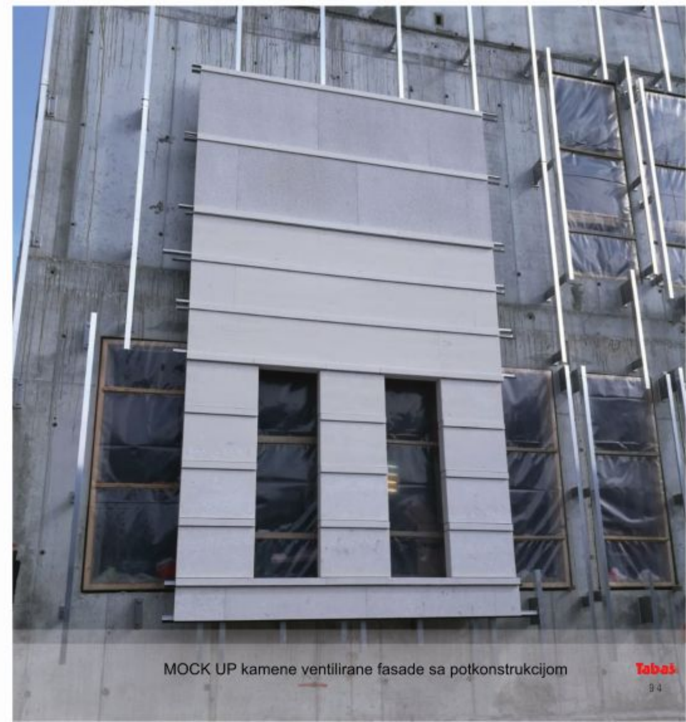
MOCK UP kamene ventilirane fasade sa potkonstrukcijom - Pazin, sa sajma MOCK UP kamene ventilirane fasade sa potkonstrukcijom - Nemačka Ambasada, Beograd
